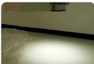
ไฟส่องพื้นใต้หัวบริการ นำทางบุคลากรเมื่อไฟห้อง OR/ICU ดับ
